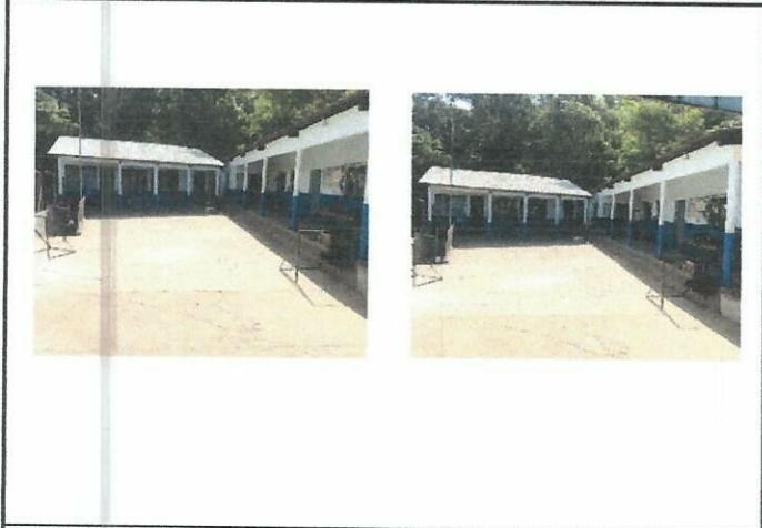
Foto1: Reparación de estructura de techo.
